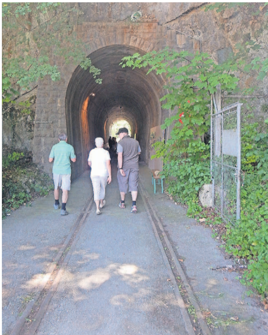
Einst nur fürs Militär zugänglich: Der Guntenflühi-Tunnel. LUKA BLUMER
