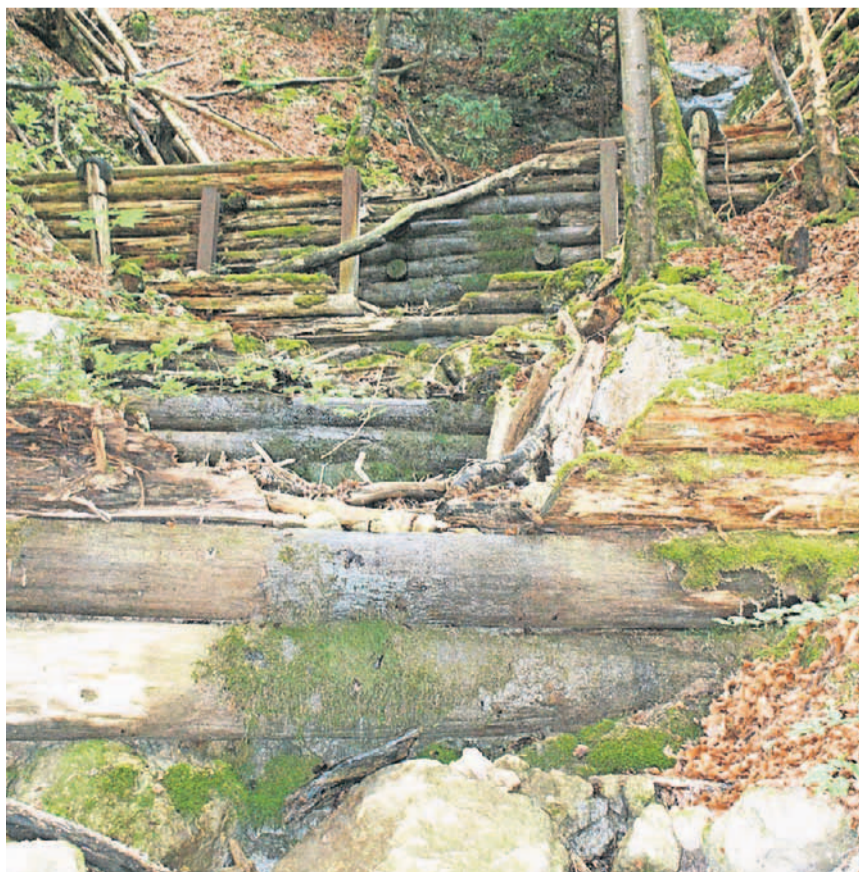
Viele der Holzkonstruktionen in den Bächen sind morsch geworden und müssen ersetzt werden.
